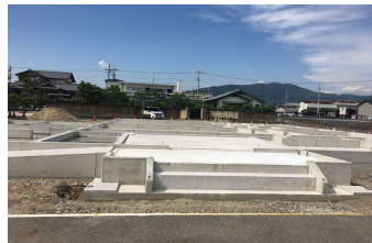
基礎工事 (R3. 5. 29撮影)
