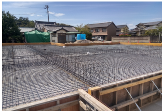
基礎工事 (R3. 4. 9撮影)
