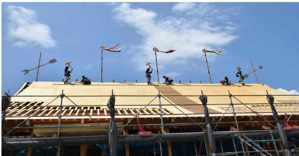
上棟祭「工匠式」槌打の儀
