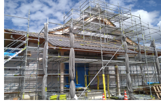
④玄関の足場と瓦ぶき
