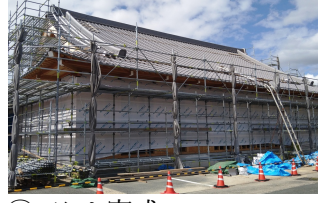
⑤瓦ぶき完成
