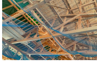
③屋根下部の頑丈な骨組み
