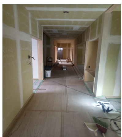
廊下・ロビー
